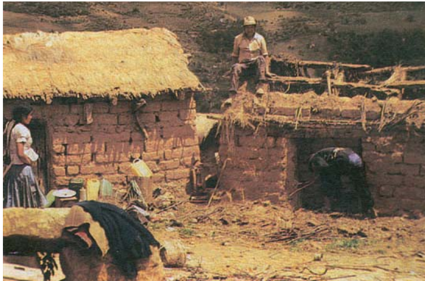
Utilización de vigas de kewiña, ( Polylepis besseri ) en el techo
