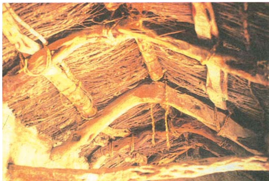
Estabilización de las vigas con la sogá.
